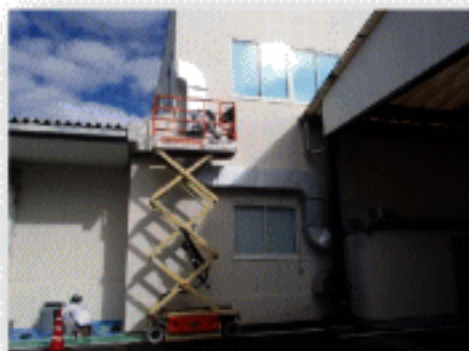
高所作業工事
