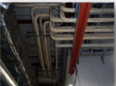
冷媒配管工事
