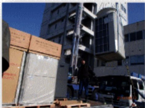
空調機搬入作業
