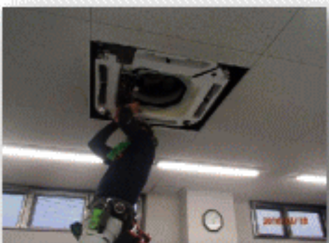
空調室内機取付
